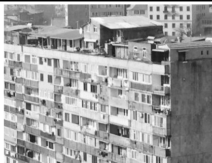
Рис. 2. Надстройка разного рода мансард на здании по 1-му тупику проспекта Баграмяна [10]
