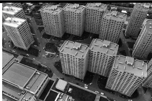
Рис. 5. Жилой комплекс по улице Царав Агбюр
