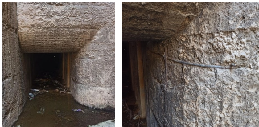
Նկ. 12. Մակերևութային ջրհեղի փականային հանգույցի մուտքամասի և դրանից հետո ե/բ պատերի պաշտպանիչ շերտի քայքայված տեսքը
