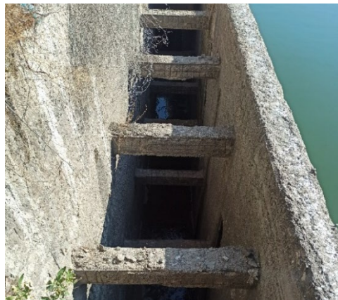
Նկ. 9. Ջրընդունիչ սրահի կոշտության հեծանների քայքայված պաշտպանիչ շերտի տեսքը
