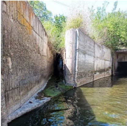
Նկ. 5. Մակերևութային ջրի հոսքի միացումը Հատակային ջրի հեռացնող ջրանցքին
