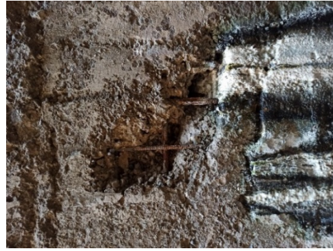
Նկ. 8. Մակերևութային ջրհեղի սրահի ե/բ պատերի քայքայված պաշտպանիչ շերտի տեսքը
