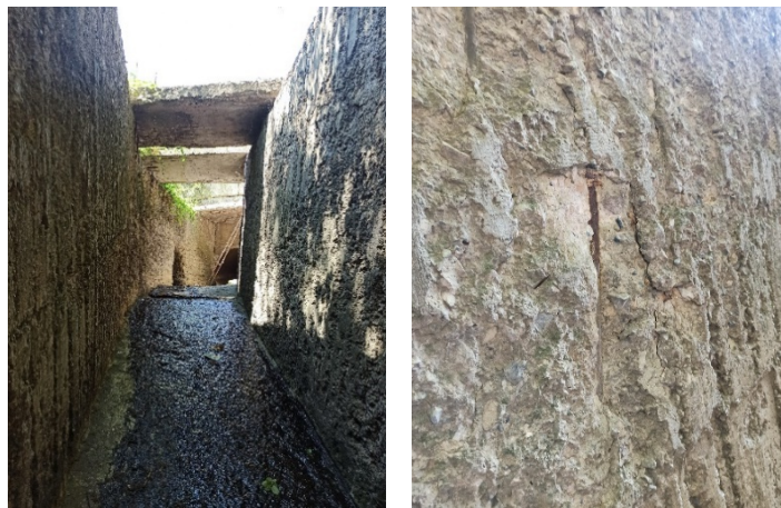
Նկ. 14. Մակերևութային ջրհեռի վերջնամասի բաց հատվածի ե/բ պատերի և հատակի քայքայված տեսքը
