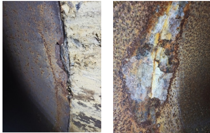
Նկ. 13. Մակերևութային ջրհեռի խողովակային հատվածի քայքայված տեսքը
