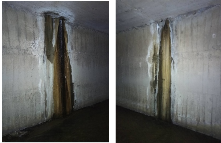
Նկ. 4. Հատակային ջրհեռի սրահի ե/բ պատերից նկատելի հոսակորուստները
