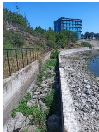
Նկ. 6. Մակերևութային ջրի հեղեղի սկզբնամասում կուտակված հատակային բերվածքների տեսքը
