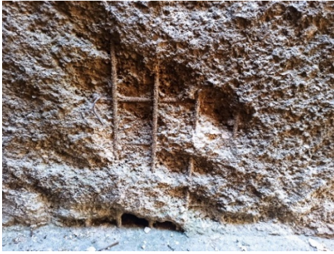
Նկ. 8. Մակերևութային ջրհեղի սրահի ե/բ պատերի քայքայված պաշտպանիչ շերտի տեսքը
