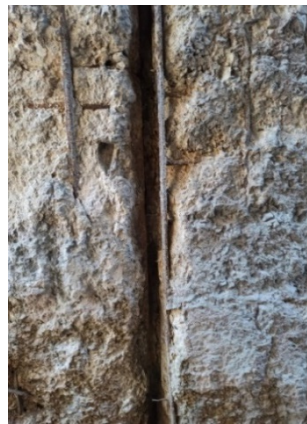
Նկ. 10. Մակերևութային ջրհեղի պատերի նստվածքադեֆորմացիոն կարերի քայքայված տեսքը
