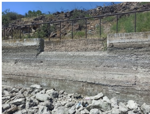
Նկ. 7. Մակերևութային ջրի հեղեղի ե/բ պատերի քայքայված պաշտպանիչ շերտի տեսքը
