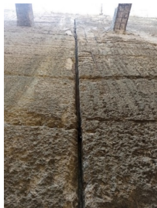
Նկ. 10. Մակերևութային ջրհեղի պատերի նստվածքադեֆորմացիոն կարերի քայքայված տեսքը
