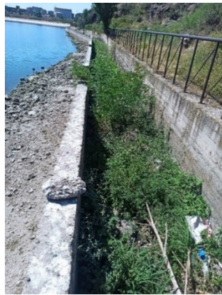
Նկ. 6. Մակերևութային ջրի հեղեղի սկզբնամասում կուտակված հատակային բերվածքների տեսքը
