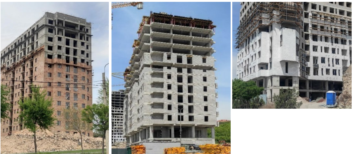
Նկ. 5, 6, 7. Արտաքին կախովի պատերն իրականացված են սակավաչափ բետոնյա բլոկներով և երեսապատված են բնական քարե սալերով
