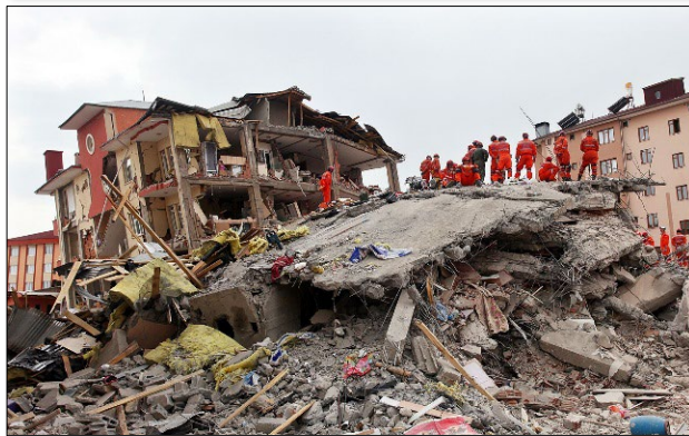
Նկ. 1, 2, 3, 4. Միրիայում, Թուրքիայում և Գրանում երկրաշարժի հետևանքով ավերակված երկաթբետոնյա շրջանակով բնակելի շենքեր
